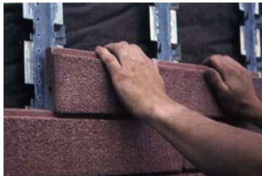
10 pav. Marmoroc apdailos plytelių tvirtinimas
