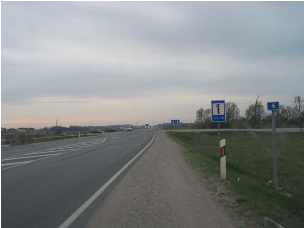
P11.10 pav. A13 Kelio Klaipėda-Liepoja ruožas 5,60-6,30 km
