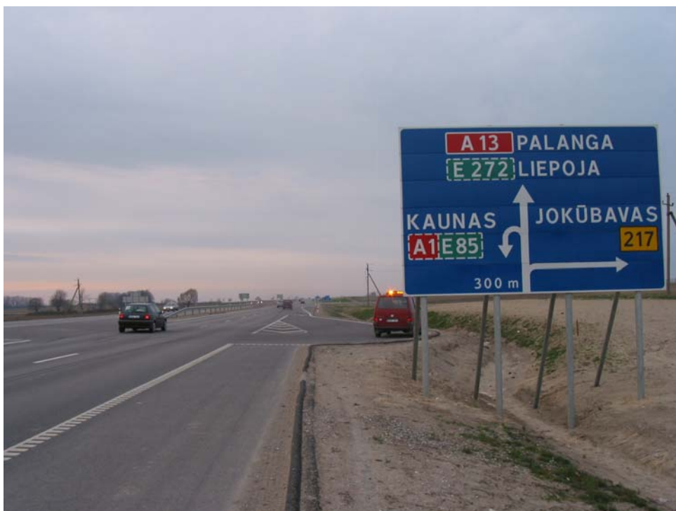
P11.9 pav. A13 Kelio Klaipėda-Liepoja ruožas 2,05-3,07 km
