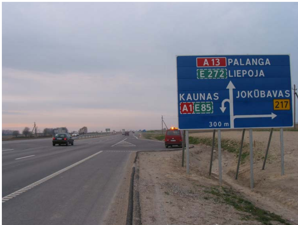
P14.9 pav. A13 Kelio Klaipėda-Liepoja ruožas 2,05-3,07 km
