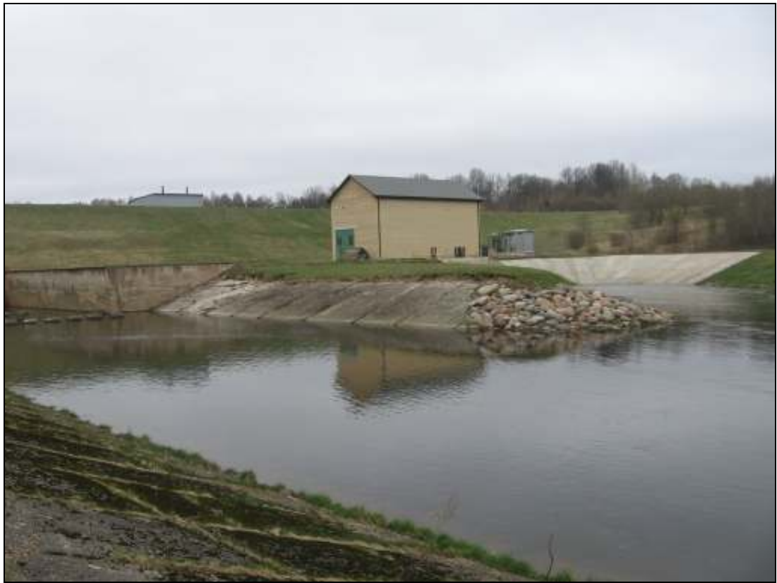
2.5 pav. Naujoji Baskų hidroelektrinė
