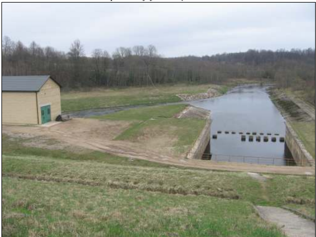
2.6 pav. Naujoji Baskų hidroelektrinė
