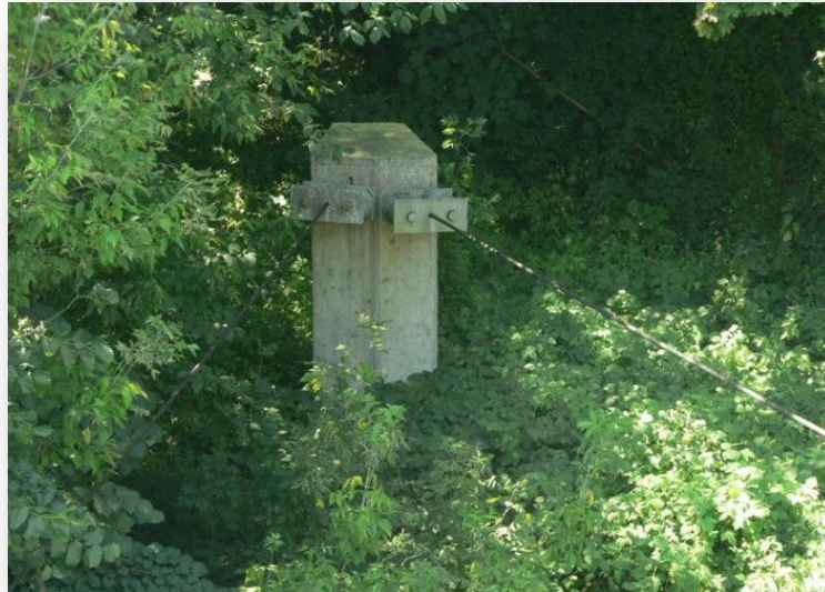
3.6 pav. Papildomų atotampų įtvirtinimas
