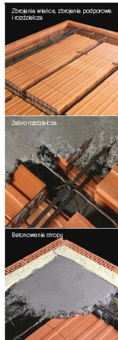
18 pav. Armatūros sudėjimas ir betonavimas
