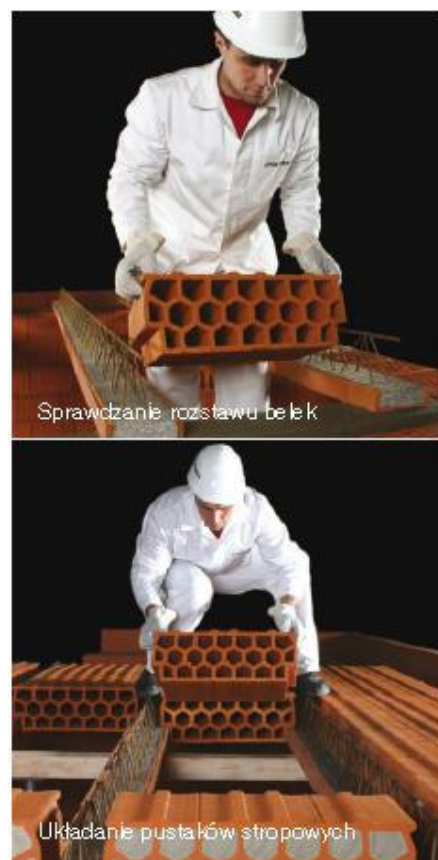
17 pav. PoroTherm Sijų ir blokelių montavimas
