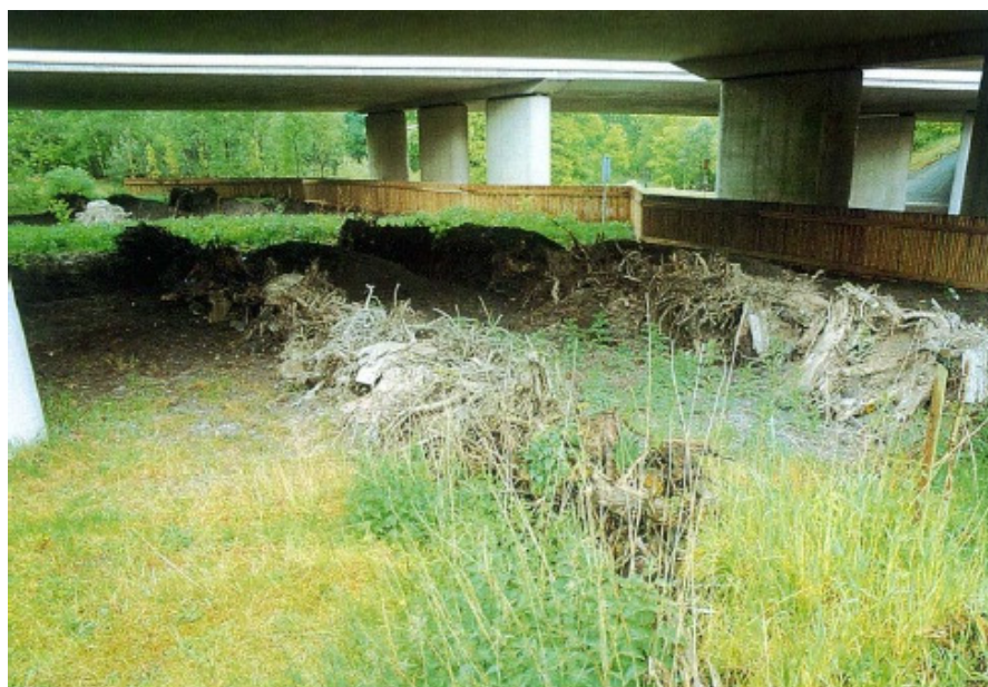
5 pav. Esamų transporto statinių pritaikymas gyvūnų migracijai [11]
