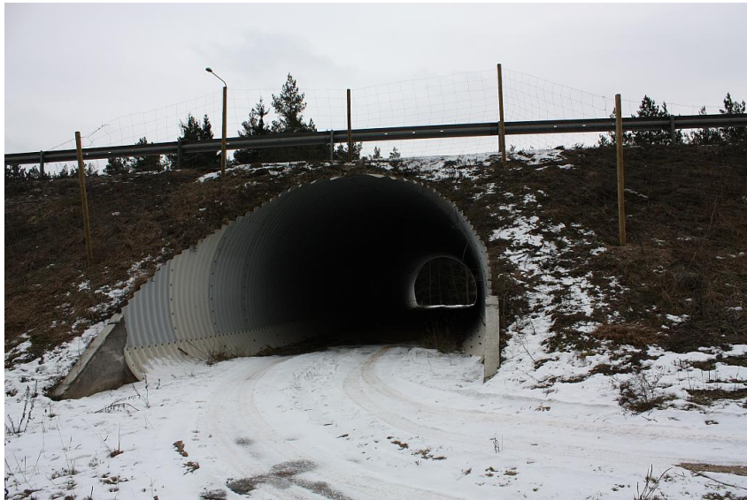
17 pav. A2 greitkelyje 21,76 km ir 37,83 km įrengta požeminė perėja
