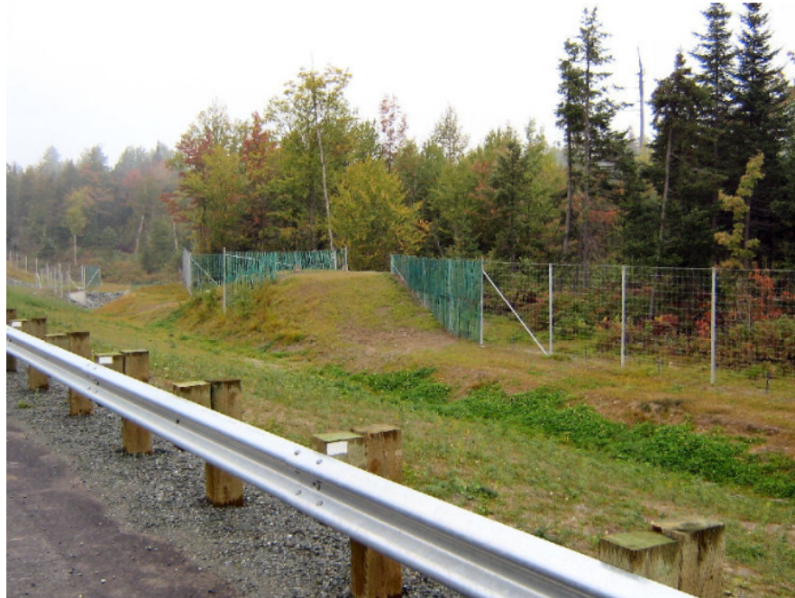
15 pav. Nušokimo rampa
