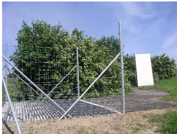
30 pav. Tinkamas horizontalaus barjero įrengimas. A – aptvėrimas iš šonų, B – įrengimas kampu
