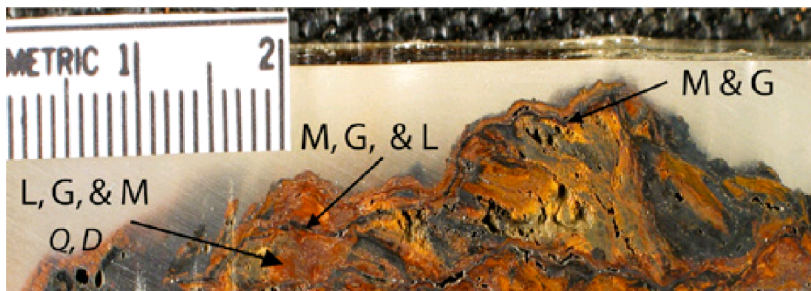
1 pav. Skaitmeninis korozijos nuogulų vaizdas 90 metų senumo ketaus vamzdyje.
