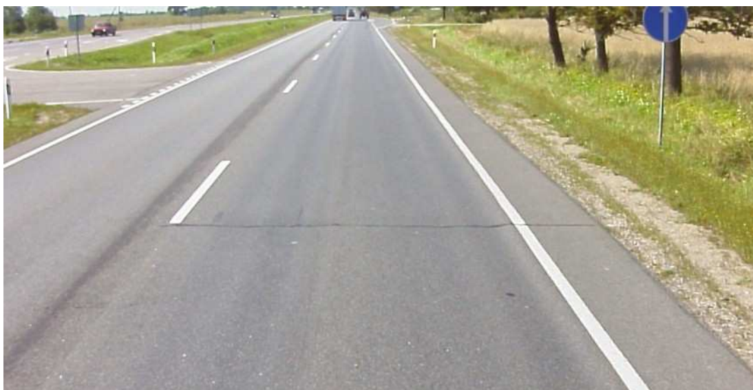
2.2 pav. Skersinis plyšys užtaisytas bitumu magistraliniame kelyje A5 Kaunas – Marijampolė-Suvalkai
