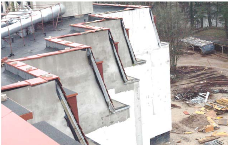
2.10 pav. Sienų apšiltinimo darbai neužbaigus stogo dengimo darbų Fig. 2.10. Wall insulation work pending the completion of roofing work
