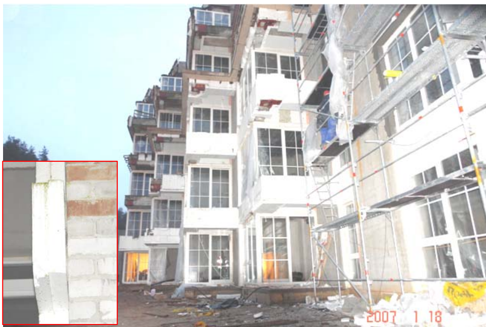
2.14 pav. Fasado apšiltinimo bendras vaizdas ir putų polistirolų plokščių klijavimo ant fasado fragmentas
