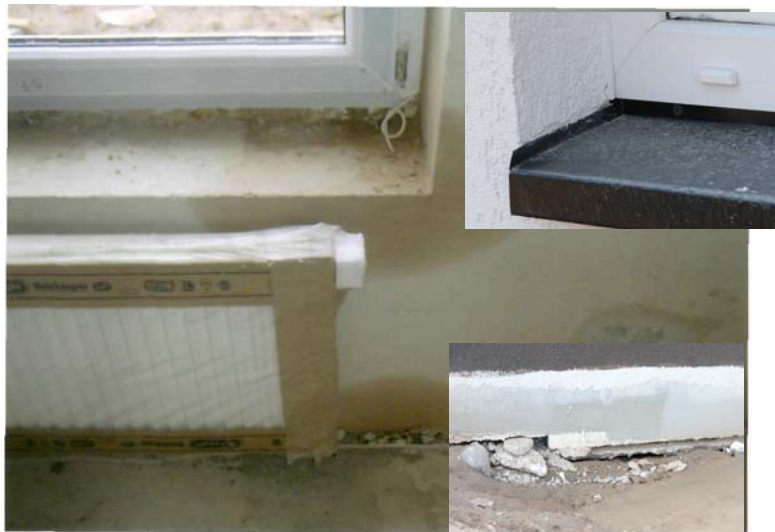
2.1 pav. Drėgmės paveiktos atitvaros
