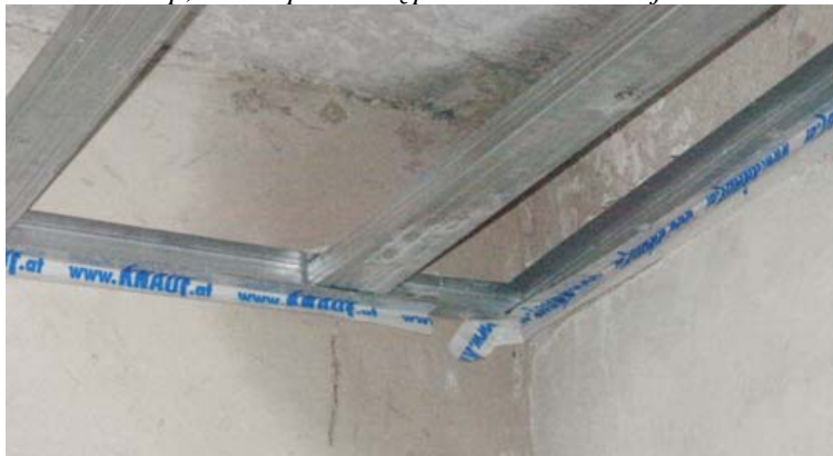
2.13 pav. Pakabinamų lubų montavimo fragmentas Fig. 2.13. Suspended ceiling installation fragment
