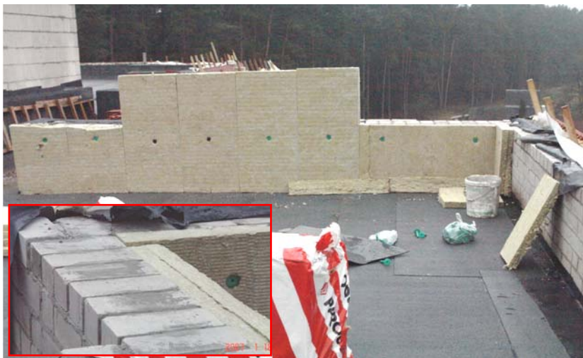
2.12 pav. Sienų apšiltinimo darbai neužbaigus stogo dengimo darbų Fig. 2.12. Wall insulation work pending the completion of roofing work
