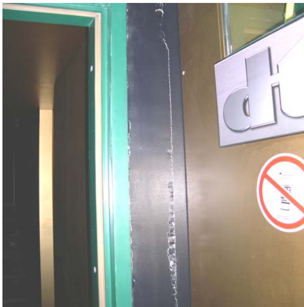
2.5 pav. Įtrūkusios sienos fragmentas
