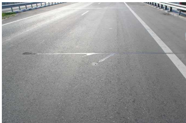
C.9 pav. Daviklių montavimas ir išdėstymas kelio dangoje
