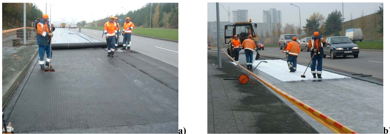
3.8 pav. Bandymų ruožo įrengimo darbai: a – geotinklo klojimas, b – geotekstilės klojimas
