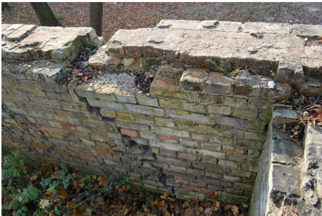
3.2.1.1 pav. A korpuso cokolio fotofiksacija
