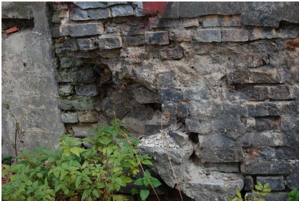
3.2.1.2 pav. A korpuso cokolio fotofiksacija
