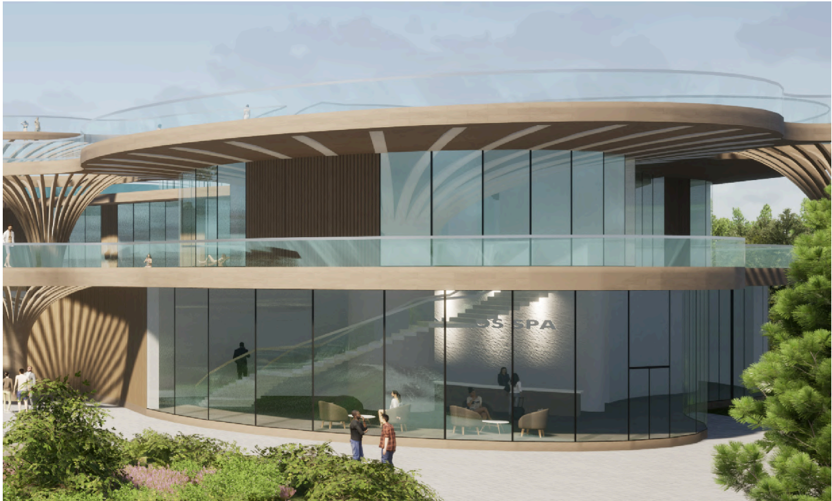
45 pav. Grybo kolona spa korpuse, laikanti stogą ir baseiną.
