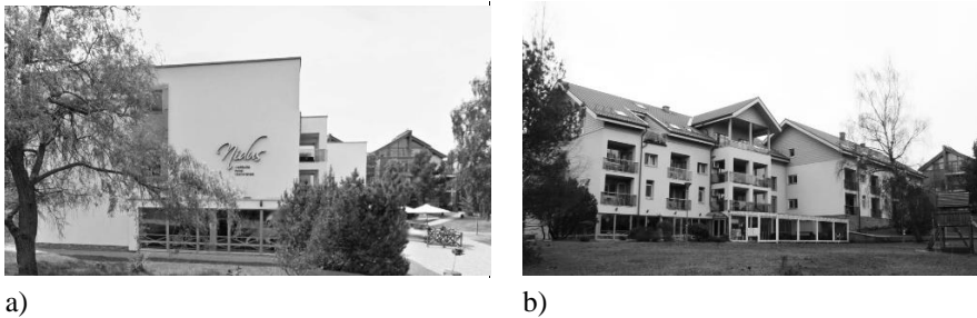
3.6 pav. a) Poilsio namų „Rūta“ I rekonstrukcija (Google Street View, 2013); b) buv. poilsio namų „Rūta“ I korpuso rekonstrukcija, dabar viešbutis „Nidus“ (G. D. Kuverto g. 15, Nida) (autorės nuotr.)
