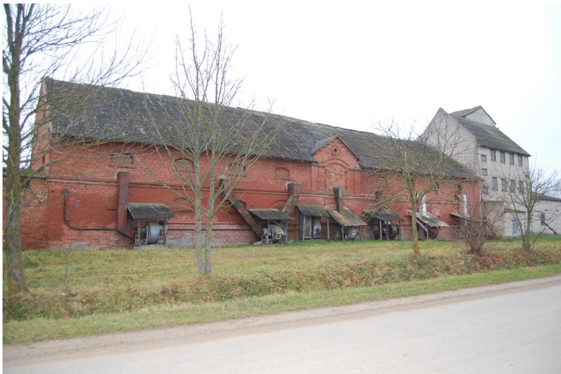
284. Buv. Versnupių (Dailučių) dvaro sodybos ūkinis pastatas. Šiaurinis fasadas. 2012 11 15. Aut. f.
