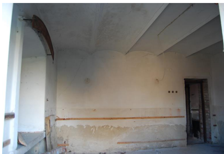
104. Keliose spirito varyklos patalpose įrengti Akermano skliautai, būdingi XX a. pr. statyboms. 2012 11 12. Aut. f.
