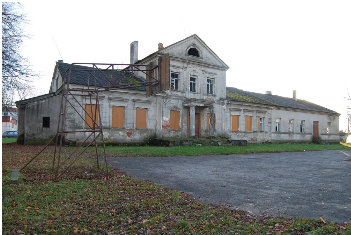
171. Buv. Klampusčių dvaras. Šiaurinis fasadas. 2012 11 04. Aut. f.
