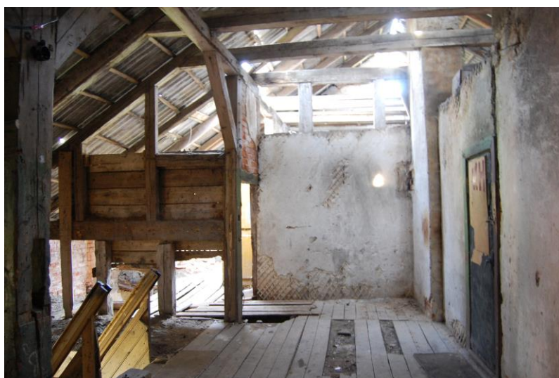
292. Antrojo aukšto patalpų fragmentas. 2012 10 04. Aut. f.
