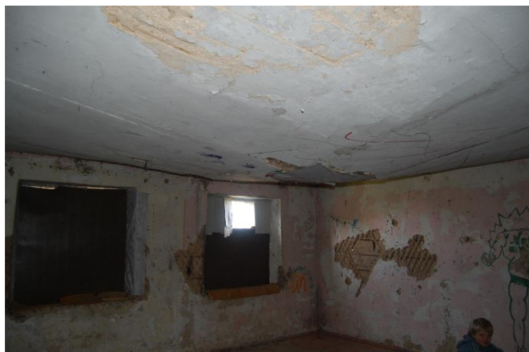
291. Antrojo aukšto patalpų fragmentas. 2012 10 04. Aut. f.
