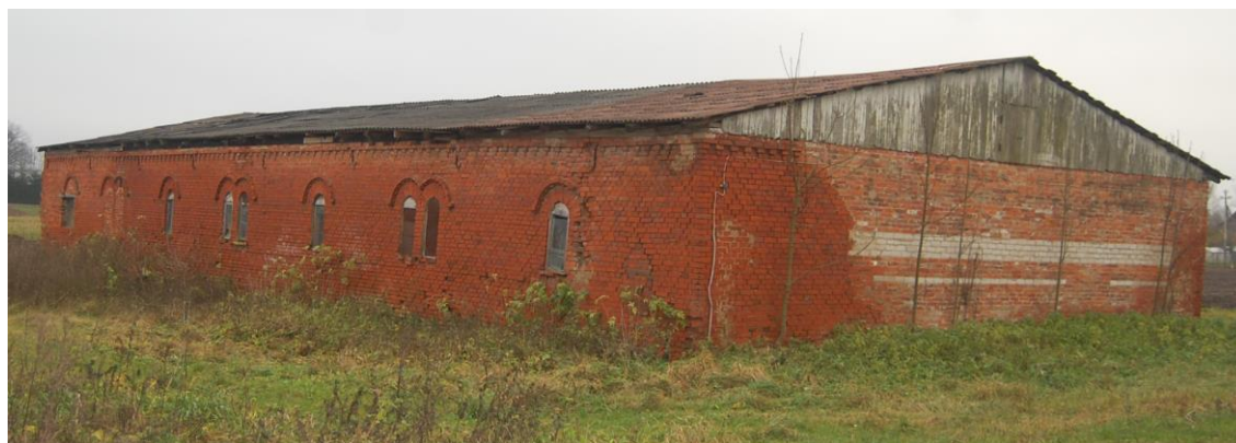
164. Ūkinio pastato liekanos. Šiaurės rytų fasadas. 2012 11 18. Aut. f.
