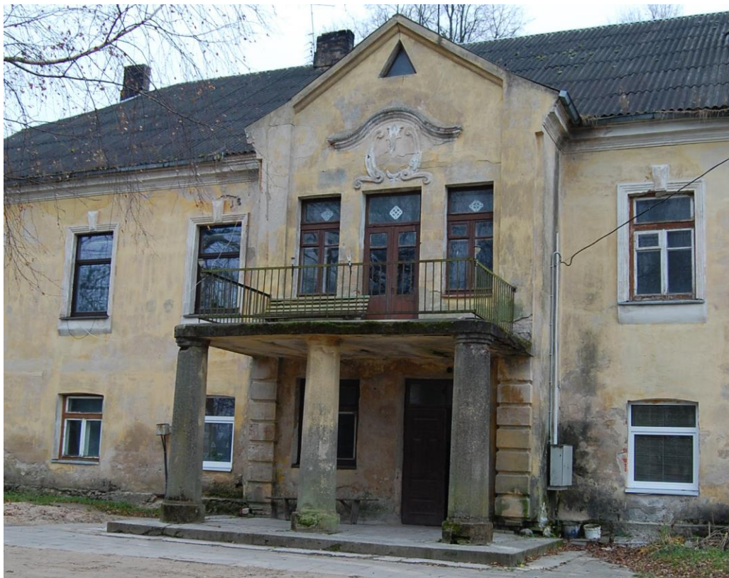
210. Šiaurės rytų fasado fragmentas. 2012 11 18. Aut. f.
