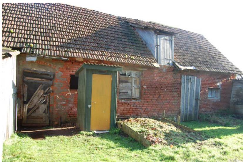
110. Ūkinis pastatas Nr.1 vakarų fasadas, naudojama pastato dalis. 2012 11 12. Aut. f.
