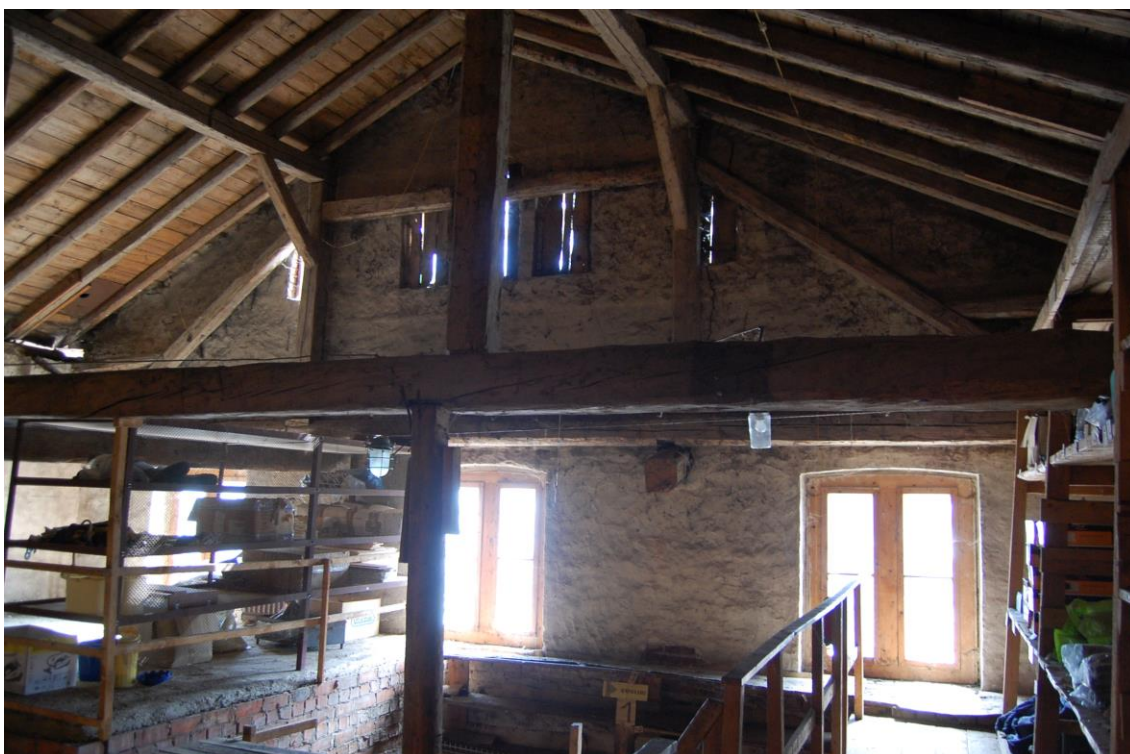
65. Gana geros būklės medinis sijų karkasas išlikęs magazino rytinėje pastato dalyje, kurioje yra detalių sandėlis. 2012 05 08. Aut. f.
