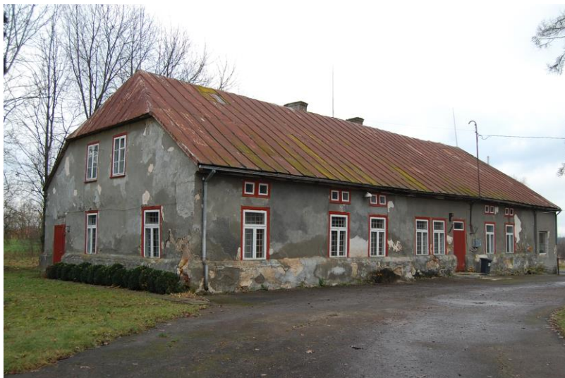
232. Buv. Rementiškių dvaro pono gyvenamasis namas. Pietryčių fasadas. 2012 12 01. Aut. f.
