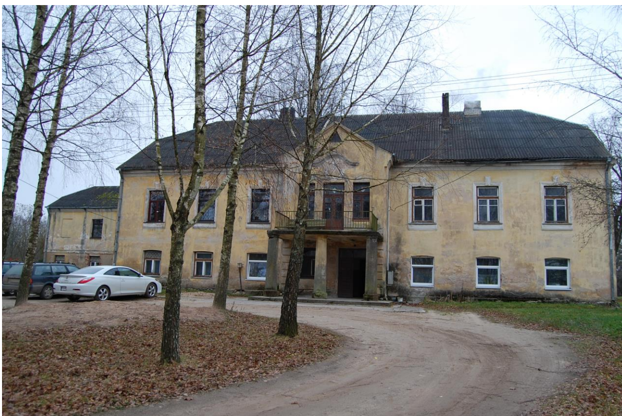
209. Putinų dvaro rūmai. Šiaurės rytų fasadas. 2012 11 18. Aut. f.
