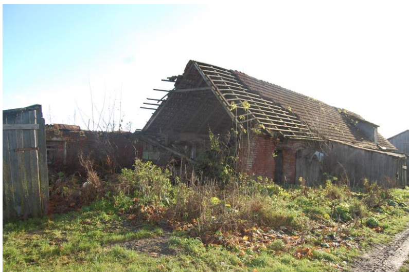
109. Ūkinis pastatas Nr.1 šiaurės vakarų fasadas. 2012 11 12. Aut. f.
