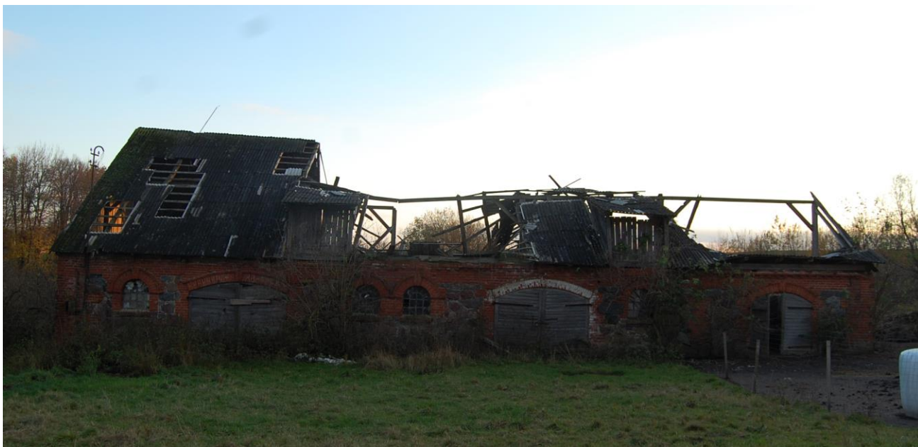
165. Buv. Kaukakalnio dvaro arklidės. Šiaurinis fasadas. 2012 11 04. Aut. f.
