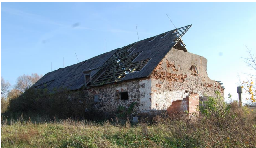
230. Ūkinis pastatas Nr. 6. Šiaurės vakarų fasadas. 2012 10 20. Aut. f
