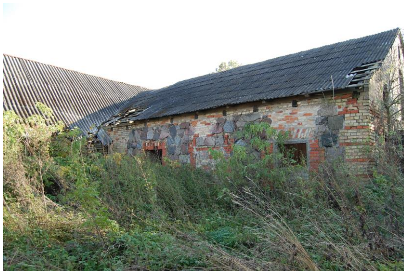
135. Buv. Dirvonų (Švitro) dvaro sodybos ūkinis pastatas. Pietvakarių fasadas. 2012 10 20. Aut. f.
