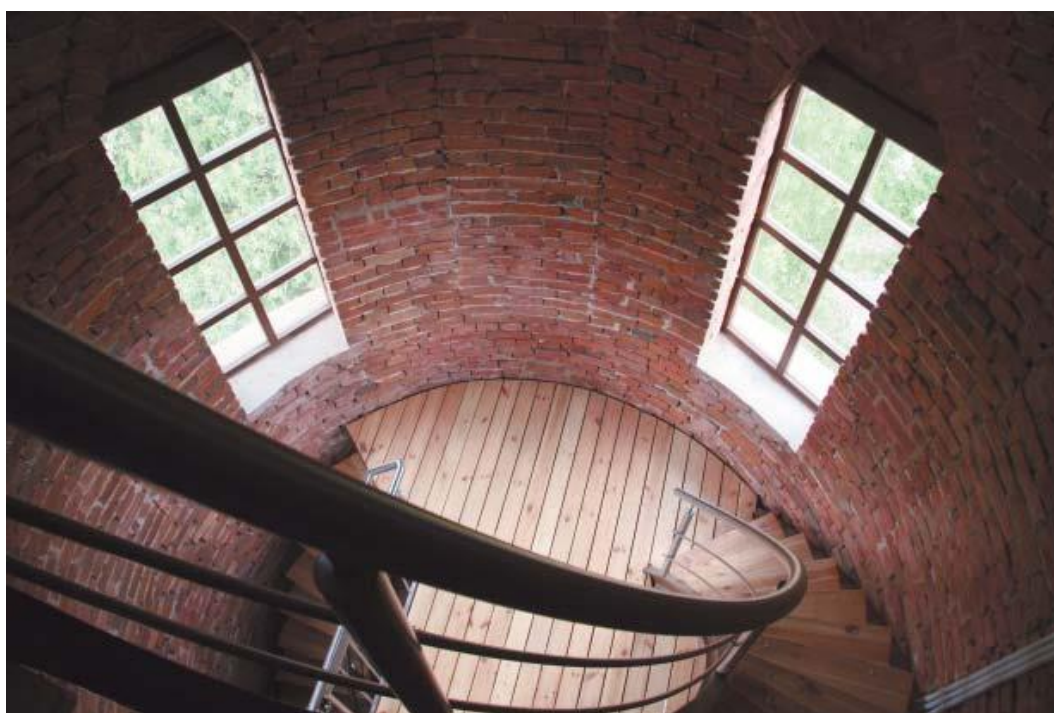
61. 2009 m. bokštui sugrąžinta pirminė jo paskirtis. Atlikus restauravimo darbus, bokšte įrengti sraigtiniai laiptai su aikštelėmis. 2011. Aut. f.
