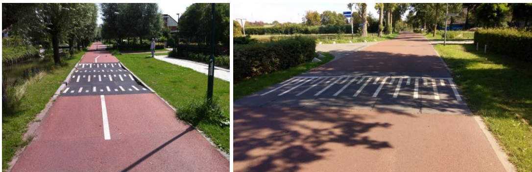
4.10 pav. Greičio mažinimo kalnelio ir iškilios sankryžos dviračių take pavyzdys, Danija (CHIPS, 2022)
