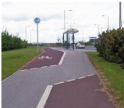
1.5 pav. Dviračių takas ties viešojo transporto stotele (VĮ Lietuvos automobilių kelių direkcija, 2012)
