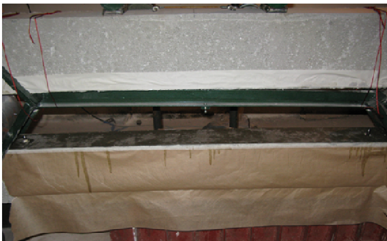
3.2 pav. Sijos tempiamo paviršiaus padengimas epoksidiniu gruntu
