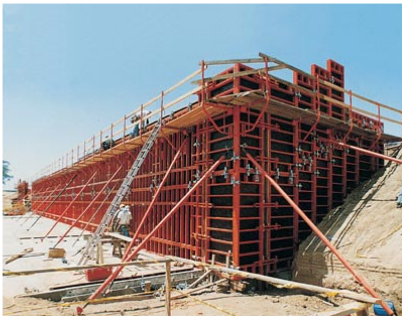
2 pav. Sieniniai klojinių skydai iš sudėtingų reguliuojamų elementų
