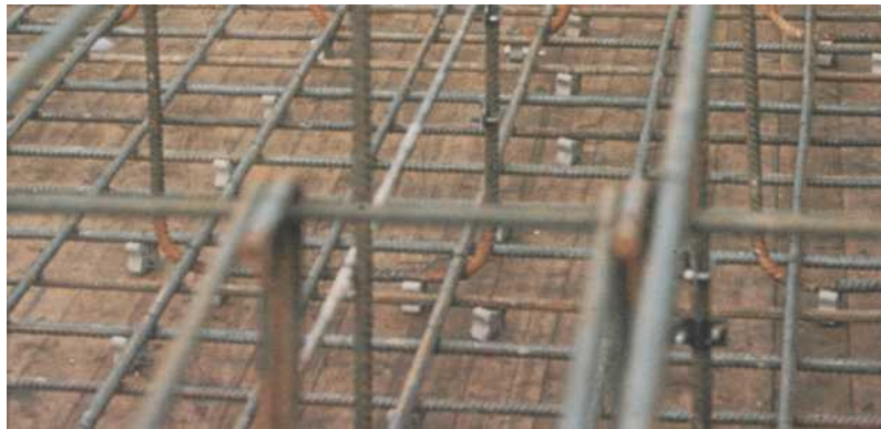
Fiksatoriai pritvirtinti prie armatūros karkaso
