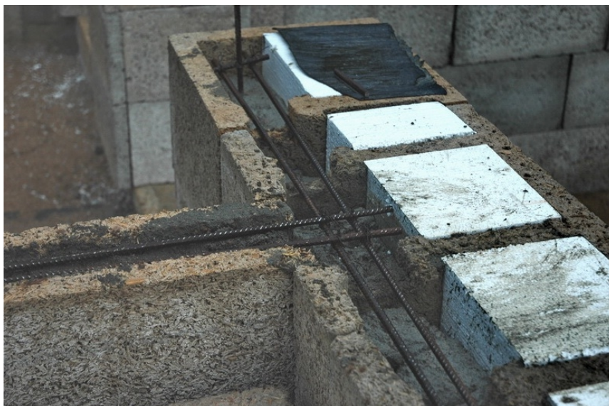
2.8 pav. Medžio cementiniai blokai [25]
