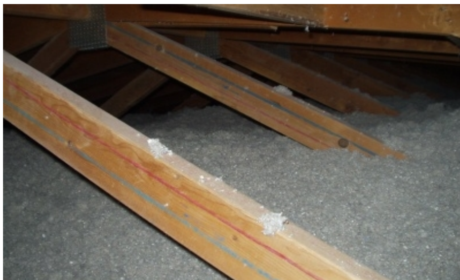
2.13 pav. Šilumos izoliacija iš celiuliozės [23]
