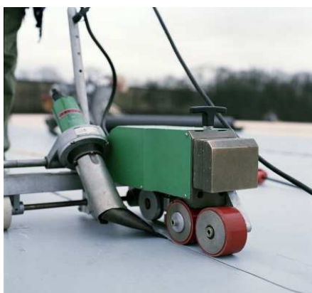
6 pav. Stogo dengimo polimerine membrana mechanizmas
