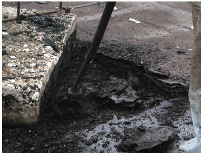
4 pav. Renovuojamas stogas
