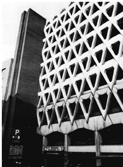
il. 13. Daugiaaukštės automobilių stovėjimo aikštelės fasadas
