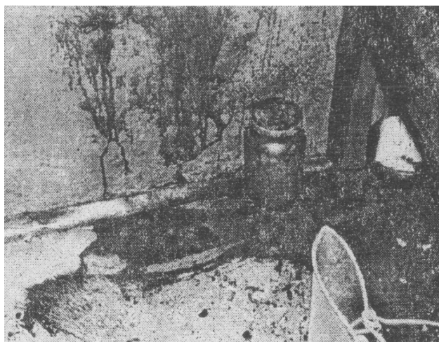
16 pav. Nukrypstančių nuo vertikalios ašies ir susikertančių nutekėjimų ant nelygaus rūšio patalpos betoninės sienos paviršiaus bendras vaizdas (Абрамов С. С. et al., 2000)
