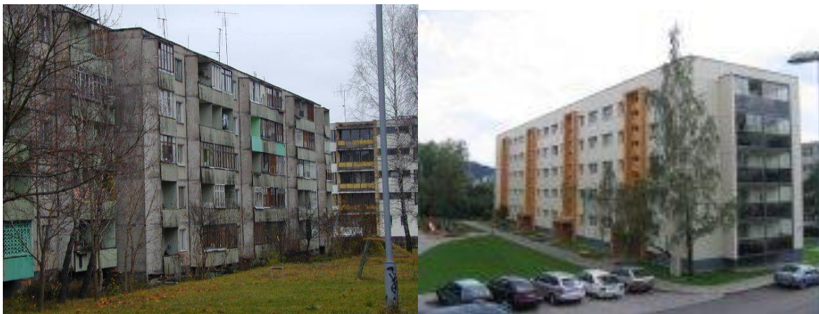
5.5 pav. Daugiabučiai namai Žirmūnuose, Vilniuje. Iš kairės nuotrauka prieš modernizaciją, iš dešinės – po modernizacijos (Atnaujink būstą 2012)
