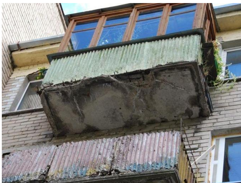
1.10 pav. Balkonų būklė (Tyrimas: dauguma... 2012)
