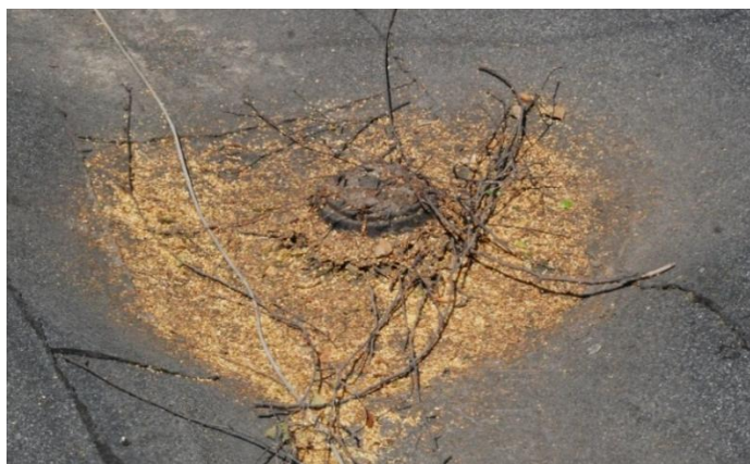
3.5 pav. Nuotėkio stovas ant pastato stogo
