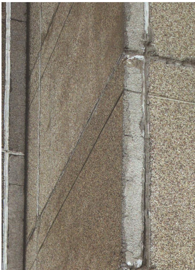
1.7 pav. Dėl siūlių nesandarumo pasislinkusi laikanti sienos plokštė (Ignatavičius 2010)
