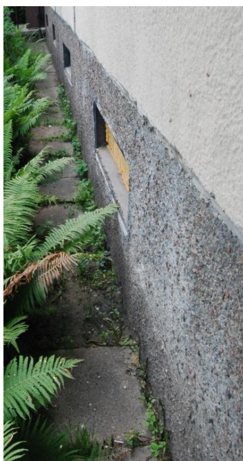
3.2 pav. Daugiabučio namo nuogrindos iš betono plytelių
