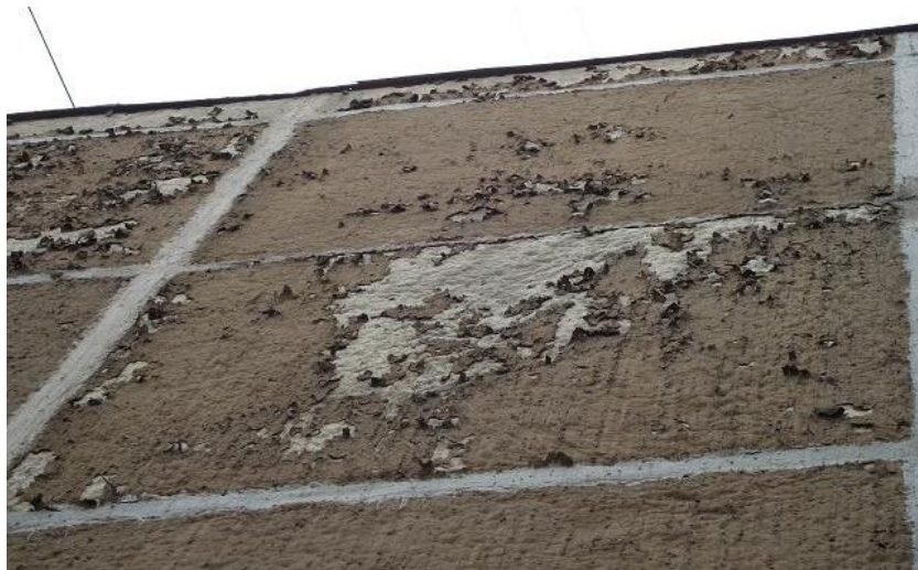
1.4 pav. Supleišėjusi pastato siena (Namo siūlių... 2012)
