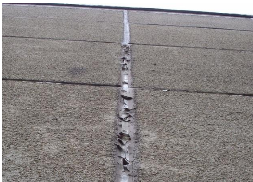
1.5 pav. Sutrūkinėjusios fasadų siūlės (Namo siūlių... 2012)
