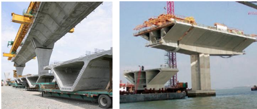
1.12 pav. Dispersinės armatūros naudojimas armuojant tiltų perdangų segmentus Fig. 1.12. The usage of fiber reinforcement in the bridge slab segments
