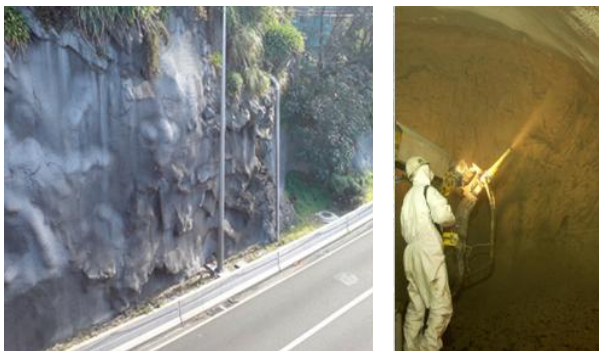
1.13 pav. Šlaitų ir tunelio sienų torkretavimas dispersiškai armuotu betonu Fig. 1.13. The filling of the slopes and tunnel walls of steel fiber reinforced concrete
