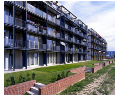
Pav. 2.7 Renovuoto pastato terasos
