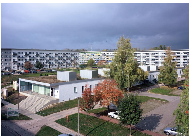
Pav.2.25 Įvairūs daugiabučių renovacijos pavyzdžiai Leinefelde
