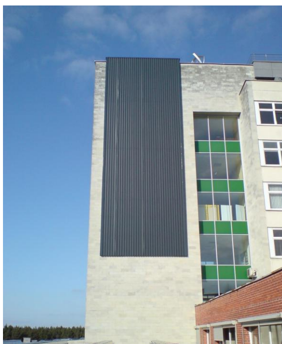
9 pav. Neįstiklinto pratakaus saulės kolektoriaus bendras vaizdas (VGTU AIF II rūmai)
