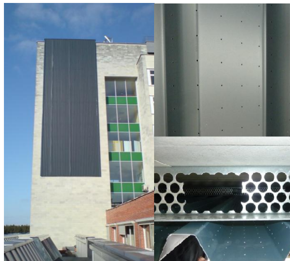
1 pav. Aplinkos inžinerijos fakulteto pratakus saulės kolektorius (kairėje – bendras vaizdas, dešinėje – kolektoriaus paviršius ir vidinė konstrukcija)
