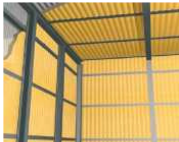
1.25 pav. Putų poliuretaną naudojamas gyvulininkystės ir agrarinės paskirties statinių šiltinimui
