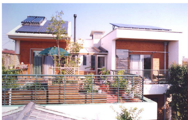
1.5 pav. Pastatas po rekonstrukcijos (Hama 2005)
