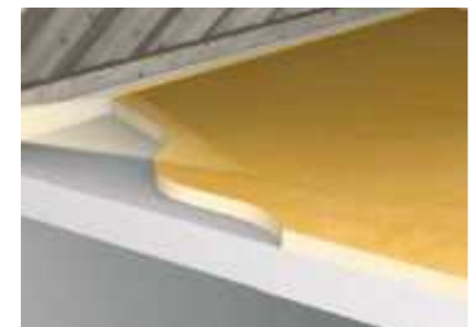
1.23 pav. Putų poliuretaną naudojamas tarpaukštinei perdangai apšiltinti
