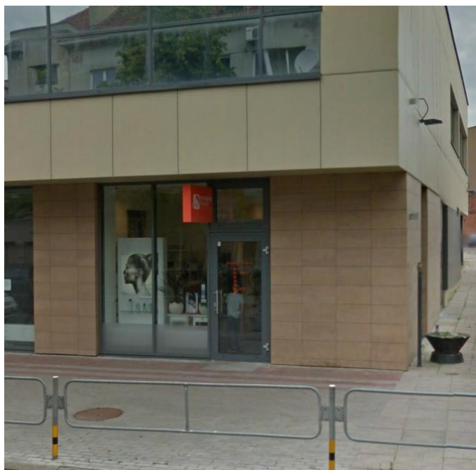
20 pav. Pritaikytas įėjimas neįgaliesiems į kirpyklą
