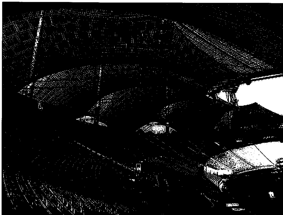
1.13 pav. Olimpino stadiono Miunchene stogo vantiniai tinklai
