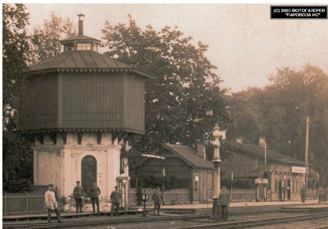
26 pav. Ignalinos geležinkelio stotis, vandens bokštas, 1910-1919 m.
