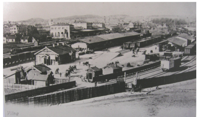
56 pav. Vilniaus geležinkelio stoties prekių kiemas, 1867 m.
