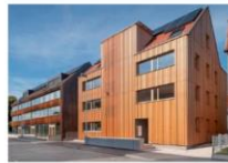
26 Neubau Eisbärhaus Bauteil C Germany | 2020 | DGNB | Platinum
