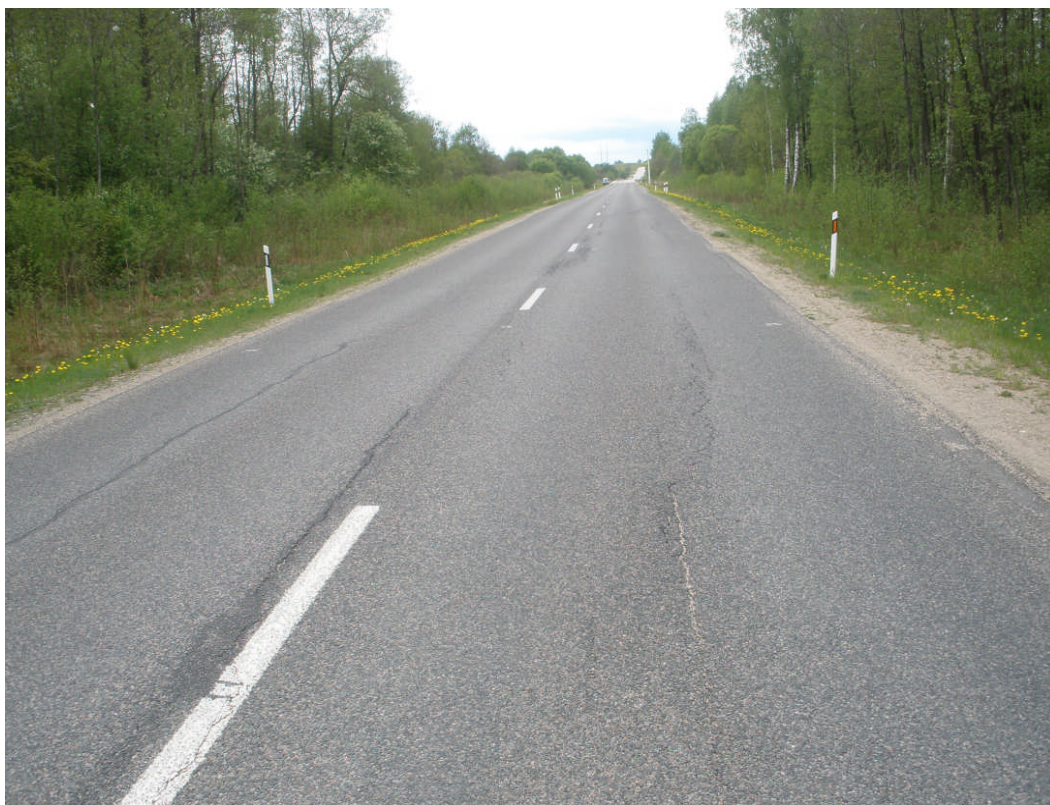
2.1 pav. Kelio žemės sankasa įrengta durpyne, nugramzdinimo būdu po 3 metų
