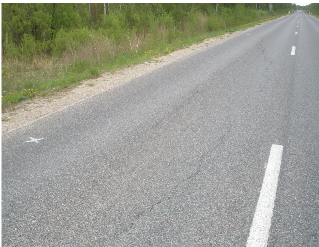
2.2 pav. Kelio žemės sankasa įrengta durpyne, nugramzdinimo būdu po 3 metų
