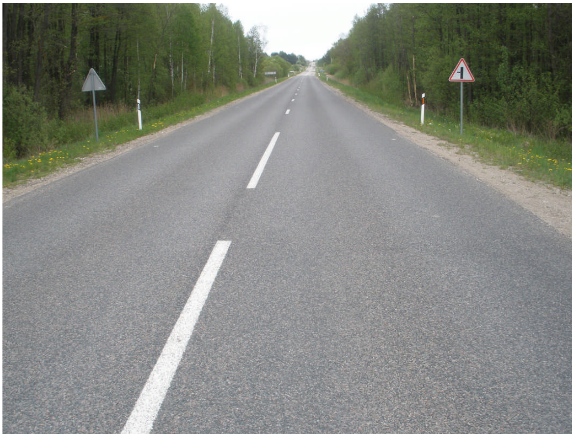
3.6 pav. Kelio dangos būklė po 3 m. kelyje Nr. 5308 Dusetos–Antazavė–Kumpuoliai
