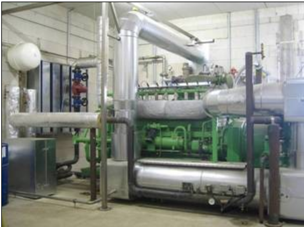
4.6 pav. Kogeneratorius JMS 208 GS-B.L
