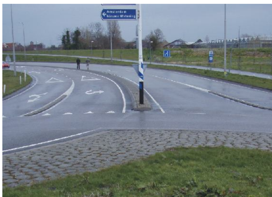
34 pav. Lašo formos skiriančioji salelė be praėjimo nenumotorizuotiems eismo dalyviams (Čibirka 2010)
