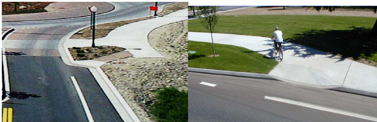
43 pav. Rampa užvažiuoti dviratininkams prieš žiedinę sankryžą, Oregonas
