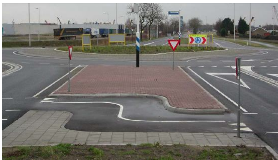
41 pav. Dviračių perėjos rokiruotė (pastūmimas), esantis visai šalia pėsčiųjų perėjos (Fortuijn 2007)
