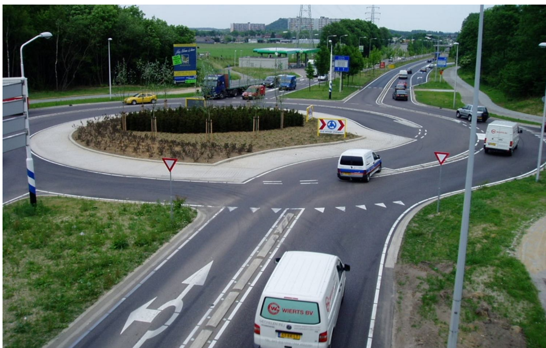
24 pav. Eismo juostų atskyrimas iškiliosiomis salelėmis, Olandija (Čibirka 2010)
