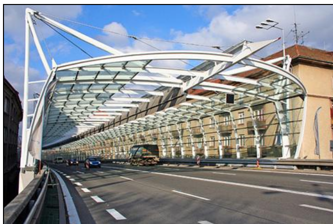
1.9 pav. Triukšminga gatvė uždengta permatoma triukšmo slopinimo konstrukcija Suomijoje (Latest in... 2010)
