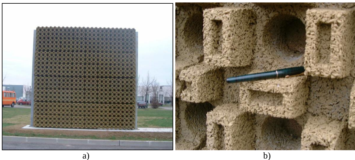
1.8 pav. Garsą atspindintis ir sugeriantis ekranas: a) bendras ekrano vaizdas; b) ekrano paviršiaus profilis (Noise barriers... 2001)
