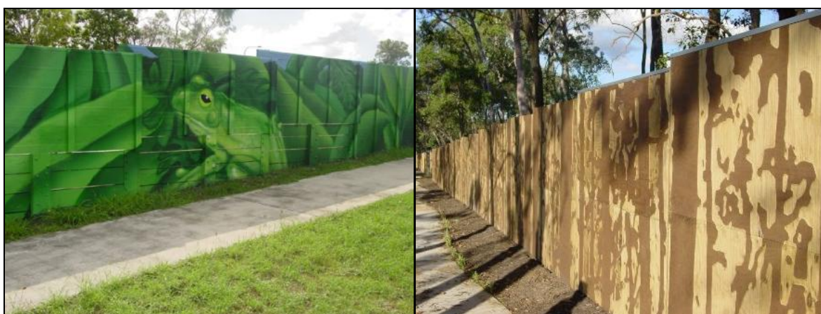
1.11 pav. Apdirbto paviršiaus (atkuriant supančios aplinkos elementus) triukšmo slopinimo sienelės Australijoje (Australian wood... 2011)
