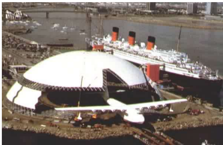
4.15 pav. Aliuminio kupolas, perdengiantis 165m skersmens angą (Ražaitis 2004)
