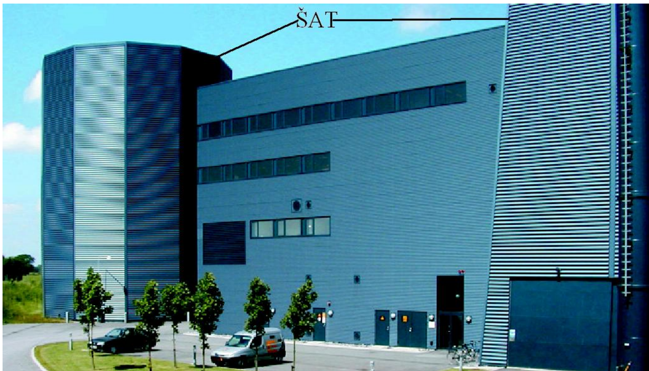
13 pav. Dviejų šilumos akumuliacijos talpų sistema, įrengta dujas deginančioje kogeneracinėje jėgainėje [8].
