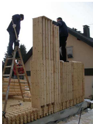
3.22 pav. Sienos plokštės bei grindų denginio jungimas per 4 elementų eilę /17/
