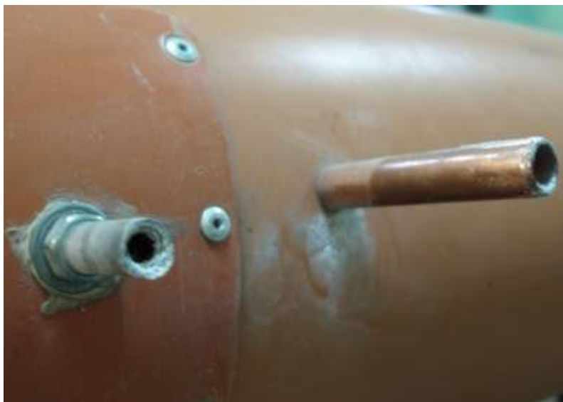
2.6 pav. Slėgio (dešinėje) ir ciklono efektyvumo nustatymo svoriniu metodu (kairėje) matavimuose panaudoti ortakio atvamzdžiai
