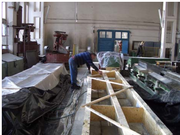
D.11 pav. KMB sijų betono laistymas vandeniu
