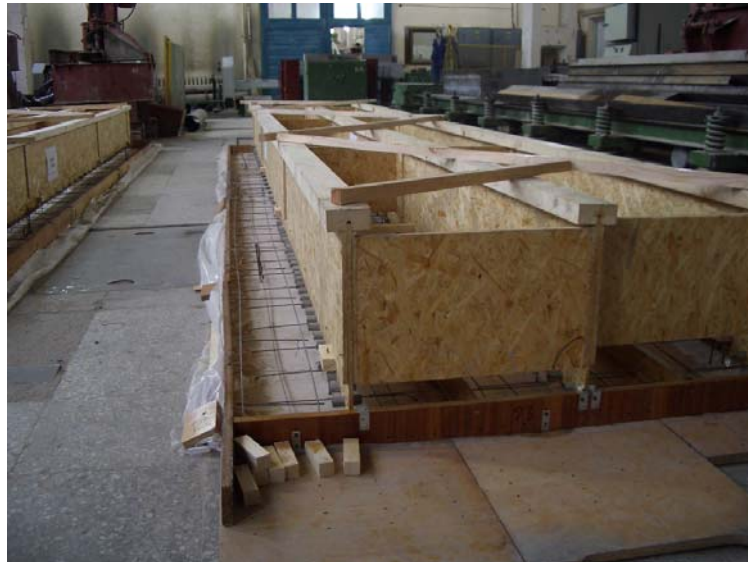
4.9 pav. Bandiniai prieš betonavimą
