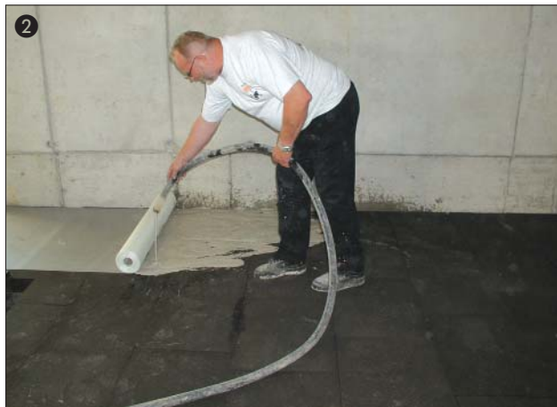
Einlegen des Gewebes PC® 150 in die Beschichtungsmasse PC® 74 A2.
