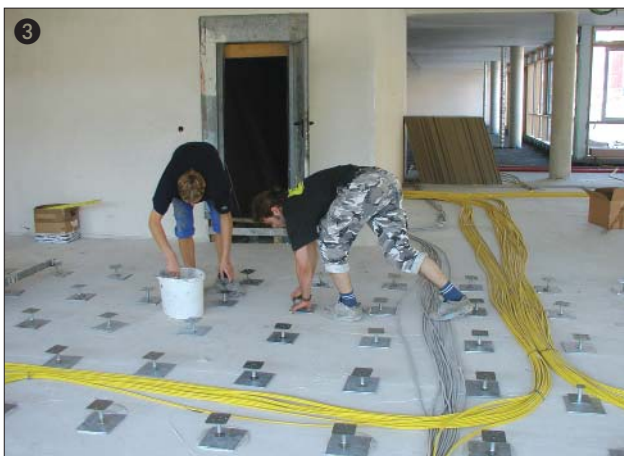
Vollflächiges Aufkleben der Stahlplatten (Lastverteilungscheiben) mit dem kriechfreien Montagekleber PC® 74 A2 im Raster des entsprechenden Doppelboden-Systems.
