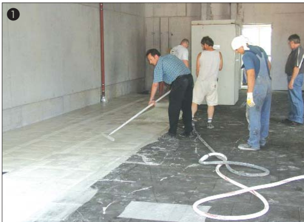
Einbringen der Deckbeschichtung aus PC® 74 A2 auf der Dämmschicht aus FOAMGLAS®-Platten T4-040.
