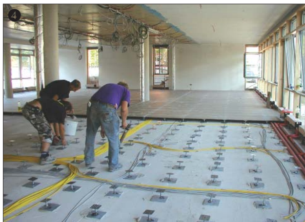
Die Stahlplatten sind in einem Kleberbett aus PC® 74 A2 verlegt; die Tellerfüße des aufgeständerten Bodensystems werden ebenfalls auf den Druckverteilterplatten mit einem Montagekleber zusätzlich gesichert.
