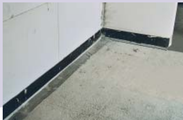
Optimal ausgebildeter Fußpunkt mit Perinsul® SL. Keine Feuchtigkeit im Mauerwerk. Folglich keine Wärmebrücke. Die Vorstellungen von Architekten und Bauphysikern können problemlos verwirklicht werden.
