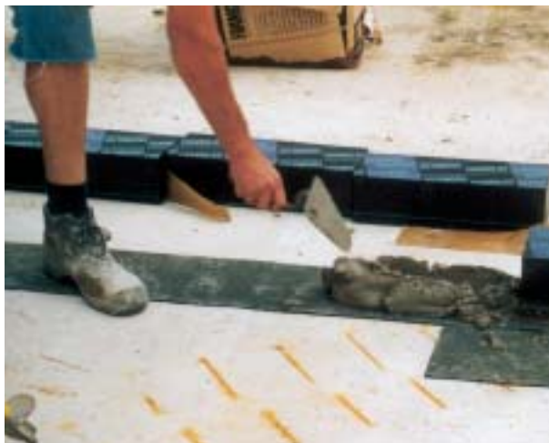
Mörtelbett zur Aufnahme des Dämmsteins.
