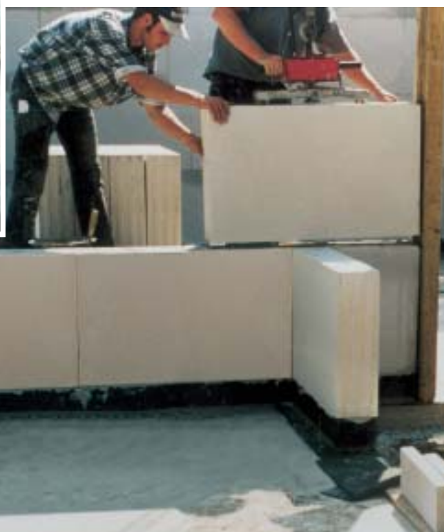
Perinsul® SL wird gleichmäßig und stumpf gestoßen unter der ersten Steinlage im Mörtelbett eingebettet.
