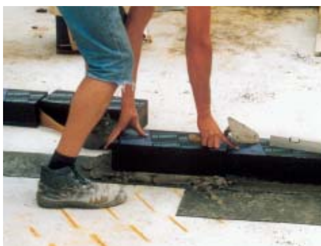
Perinsul® SL wird gleichmäßig und stumpf gestoßen unter der ersten Steinlage im Mörtelbett eingebettet.
