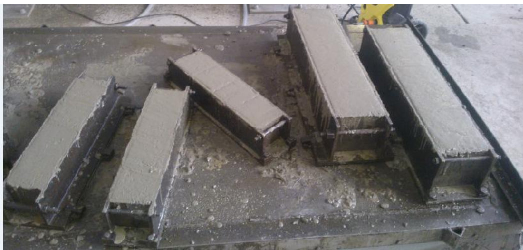
4.6 pav. Bandinių, skirtų betono savybėms nustatyti, betonavimas
