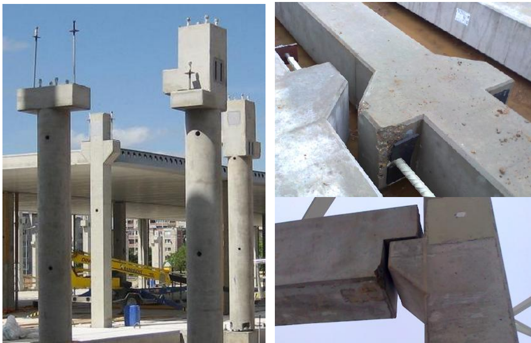
1.4 pav. Trumpų sijų praktiniai pavyzdžiai (Tuchscherer 2008)
