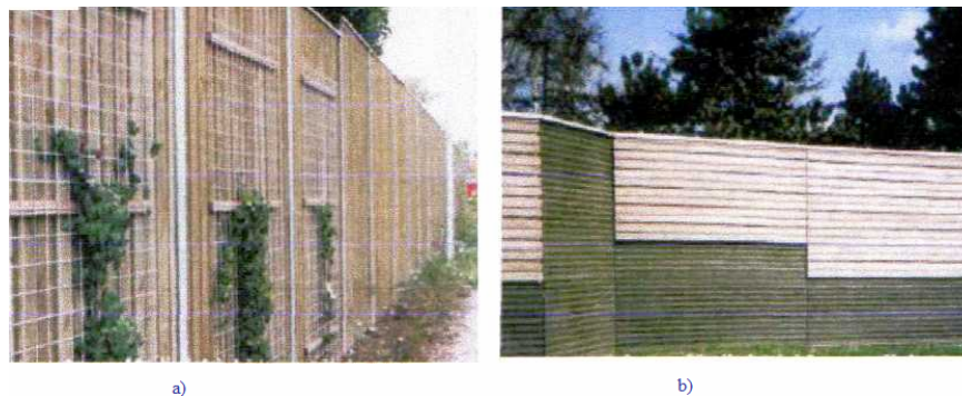
1.10 pav. Triukšmą izoliuojančios medinės užtvartos
