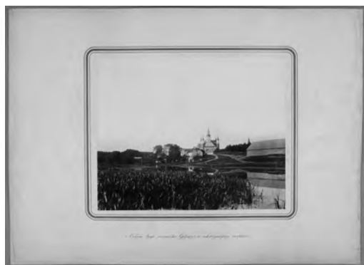
m) Bendras Supraslės miestelio vaizdas iš šiaurės vakarų pusės
