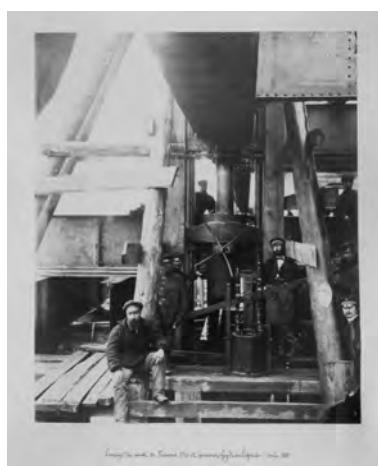
f) Kauno tilto kėlimas, hidraulinio preso vaizdas. 1861 m. spalio
