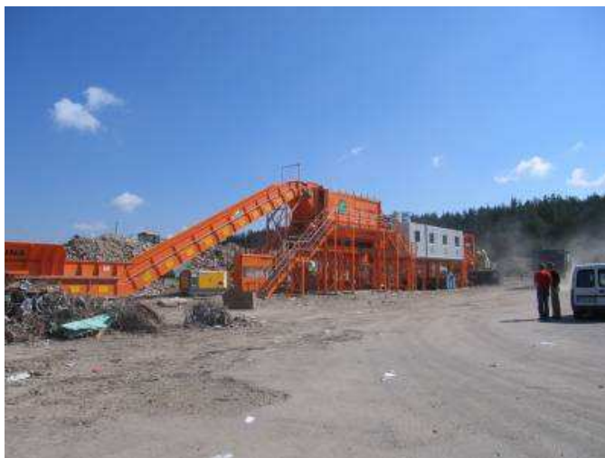
2 pav. Statybos atliekų perdirbimas griovimo aikštelėje [13]
