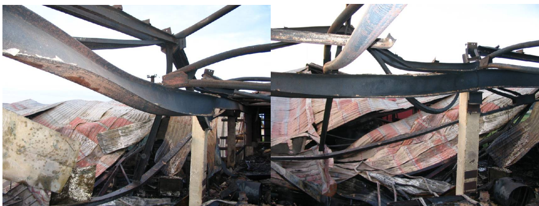
1 pav. Gaisro poveikis neapsaugotoms plieninėms konstrukcijoms [Nuotraukos iš autoriaus asmeninio archyvo]
